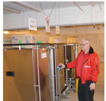
Automatisierung der AWT-Anlage mindert körp. Belastung (Kostenträger: Integrationsamt)
