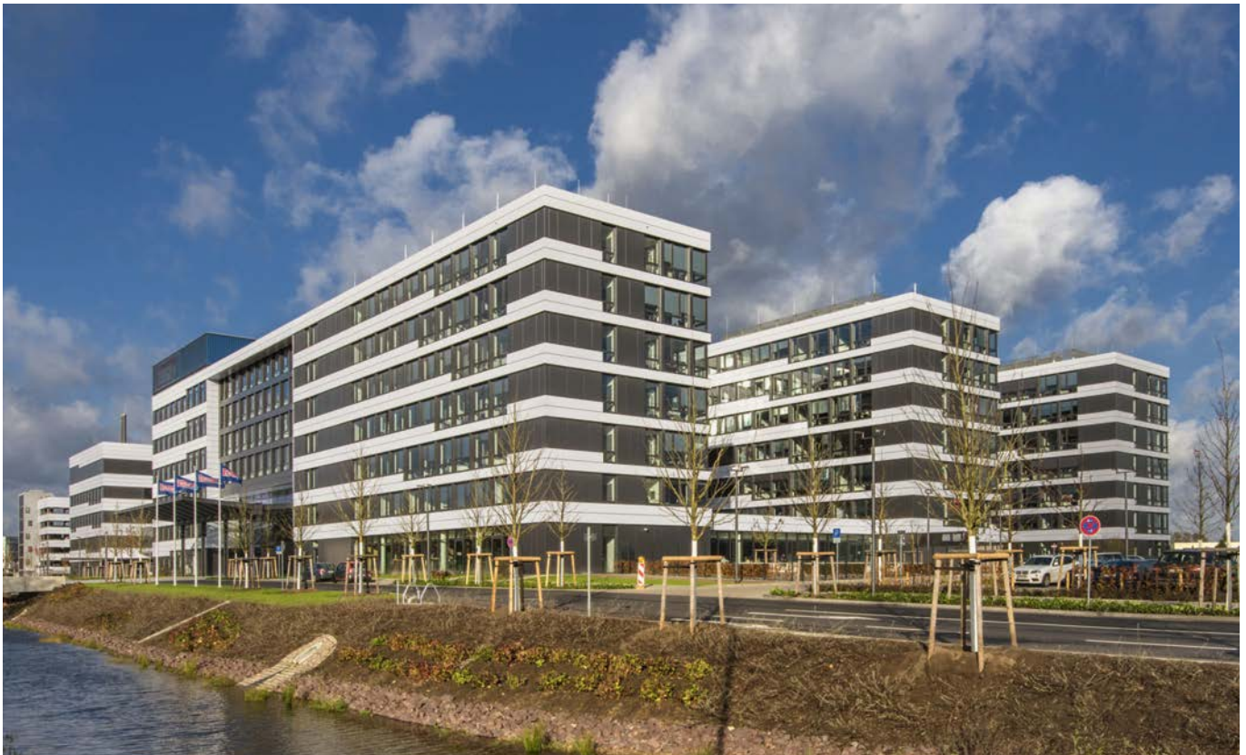
Aus drei mach ein: Neubau der tesa SE in Norderstedt
